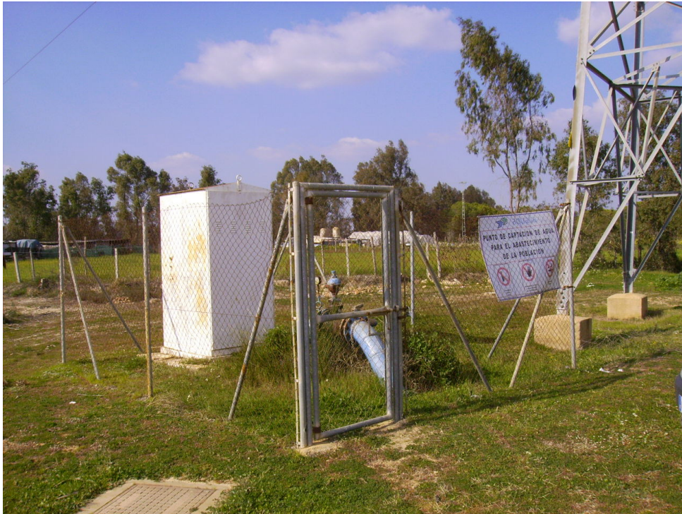
Sondeo de abastecimiento estación eléctrica (1142-1-0049).
