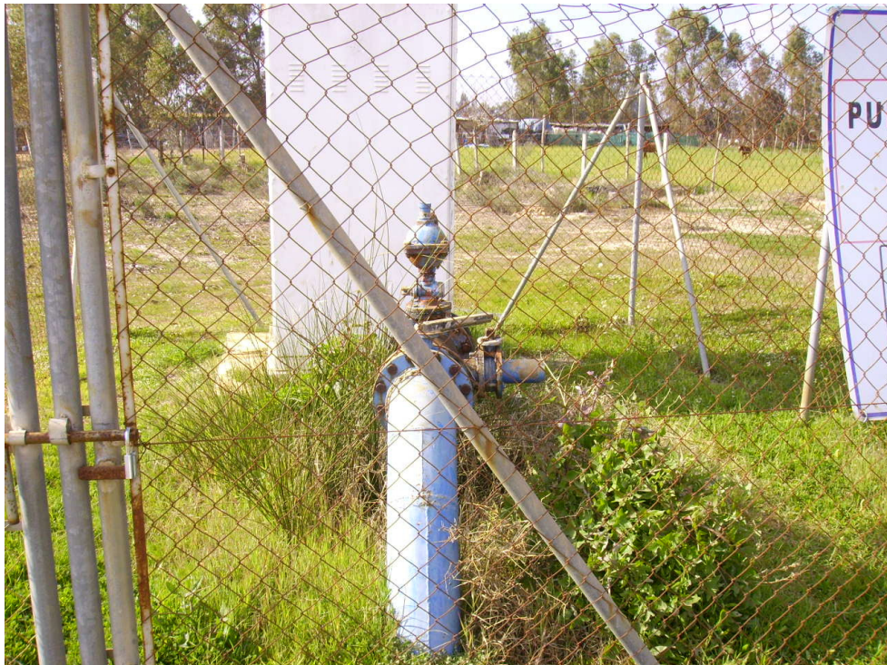
Sondeo de abastecimiento estación eléctrica (1142-1-0049).
